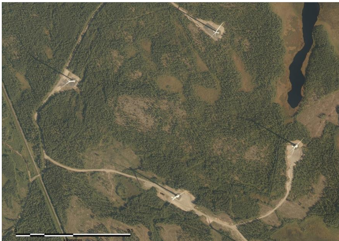
Kuva 72. Ilmakuvassa näkyy toiminnassa olevia tuulivoimaloita. Tuulivoimaloita varten on rakennettu huoltotiet ja nostokentät. Tuulivoimaloiden ympäristössä ja välialueilla aikaisempi maankäyttö on säilynyt ennallaan.
