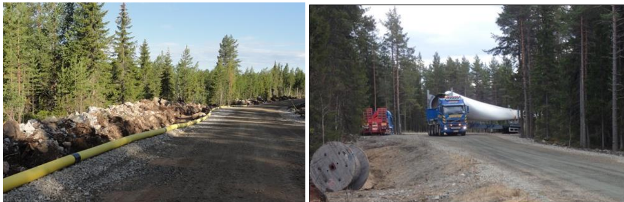
Kuva 78. Vasemmalla kuvassa on esimerkki tuulivoimapuiston rakennus- ja huoltotiestä. Teitä käytetään muun muassa betonin, soran ja voimaloiden komponenttien kuljetuksiin sekä tuulivoimapuiston käyttöväheessä huoltoajoihin. Maakaapeli sijoitetaan ojakaivantoon tien reuna-alueelle. Oikealla kuvassa tuulivoimalan osia kuljetetaan erikoiskuljetuksina. (Kuvat: Ville Suorsa / FCG).
