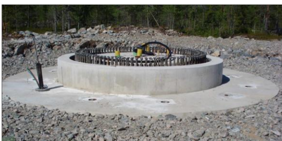
Kuva 6-3. Esimerkkikuva kallioankkuroidusta perustuksesta vierustäyttöjen jälkeen.
