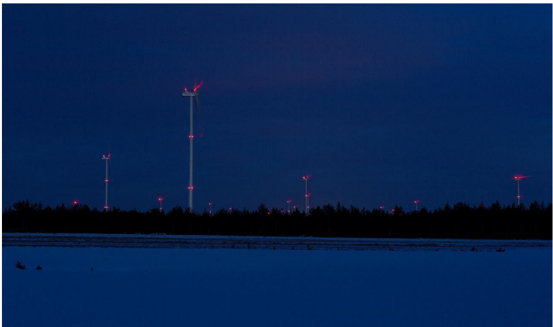
Kuva 2-14. Kiinteät punaiset lentoestevalot. (Kuva: Ville Suorsa, FCG)
