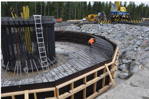
Kuvapari 2-20. Tuulivoimalan perustusten rakentamista. (Kuvat: Leila Väyrynen, FCG)
