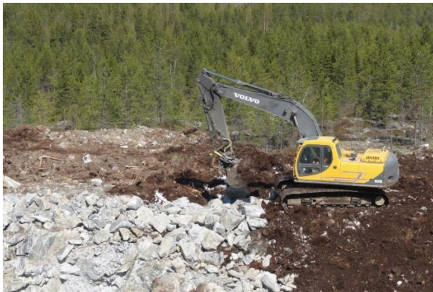
Kuvapari 2-18. Tuulivoimapuiston rakentaminen alkaa huoltoteiden ja voimalapaikkojen rakentamisella (kuvat: Ville Suorsa, FCG).
