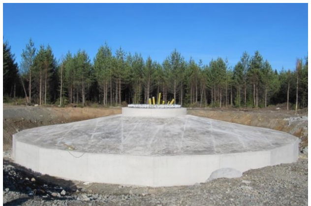
Kuvapari 2-20. Tuulivoimalan perustusten rakentamista. (Kuvat: Leila Väyrynen, FCG)
