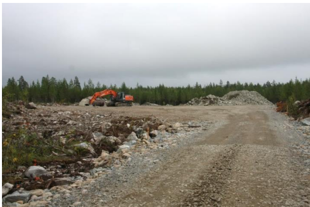
Kuvapari 2-18. Tuulivoimapuiston rakentaminen alkaa huoltoteiden ja voimalapaikkojen rakentamisella (kuvat: Ville Suorsa, FCG).
