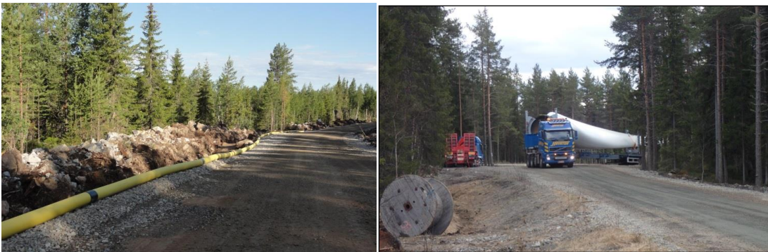
Kuva 2-16. (Vasemmalla) Esimerkki tuulivoimapuiston rakennus- ja huoltotiestä rakentamisaikana. Teitä käytetään muun muassa betonin, soran ja voimaloiden komponenttien kuljetuksiin sekä tuulivoimapuiston käyttövaiheessa huoltoajoihin. Maakaapeli sijoitetaan ojakai- vantoon tien reuna-alueelle. (Oikealla) Tuulivoimalan osia kuljetetaan erikoiskuljetuk- sina. (Kuvat: Ville Suorsa / FCG).
