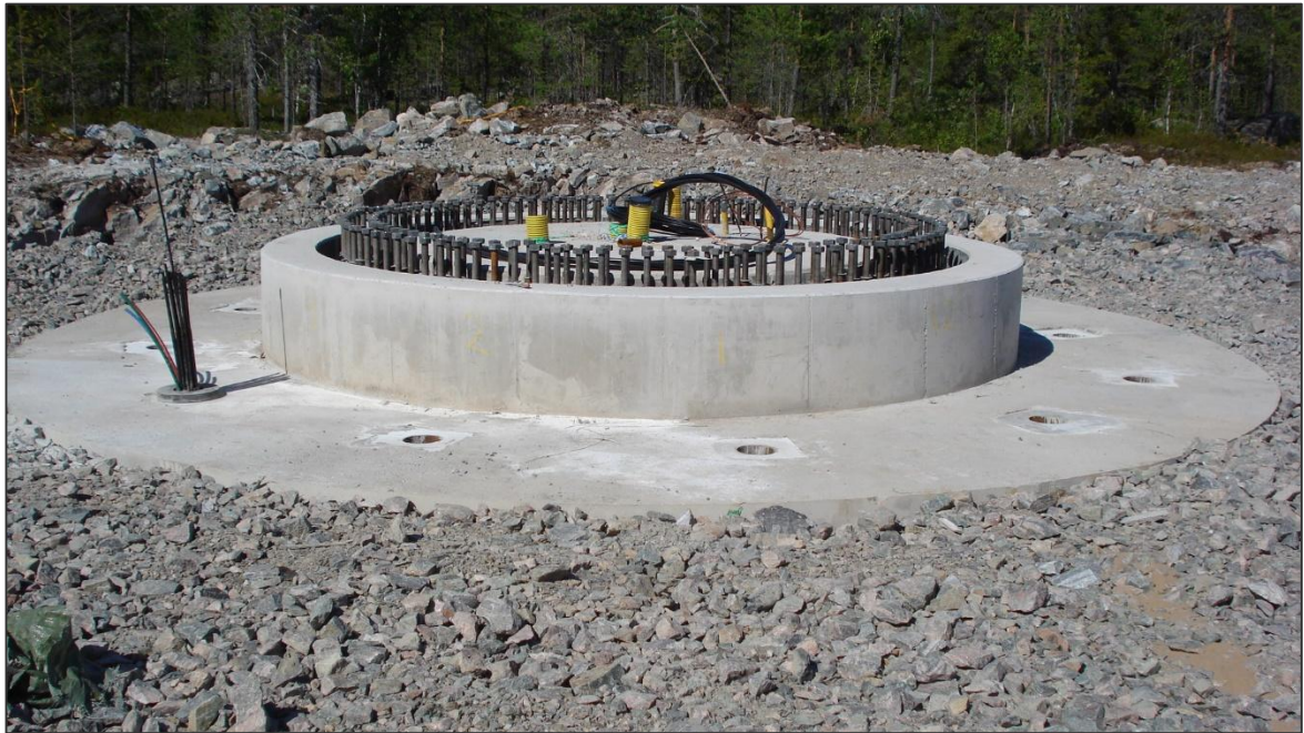
Kuva 3-6. Kallioankkuroitu teräsbetoniperustus (YIT Suomi Oy)
