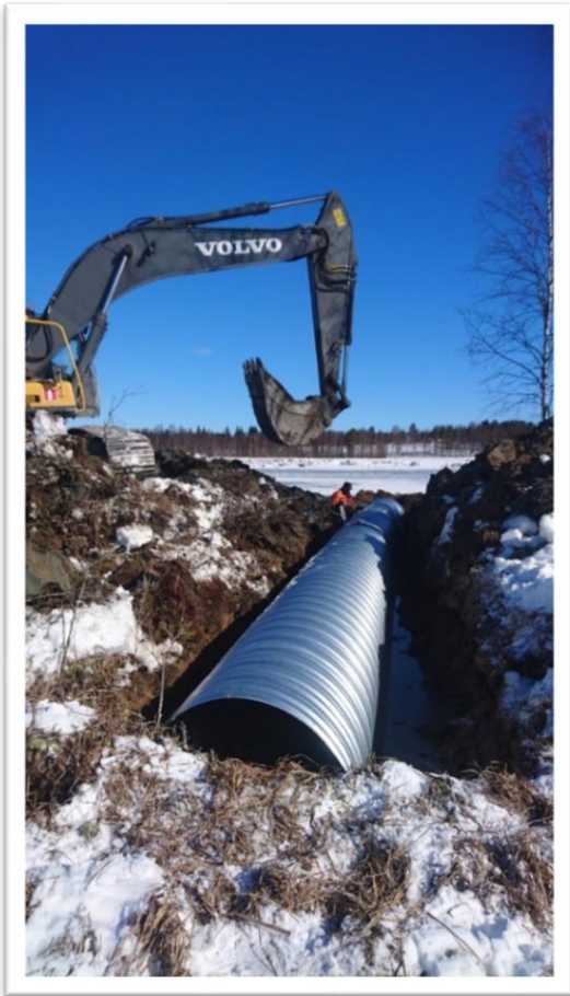
KUVA 5 . Suonenlahden rumpujen asennusta 2017.
