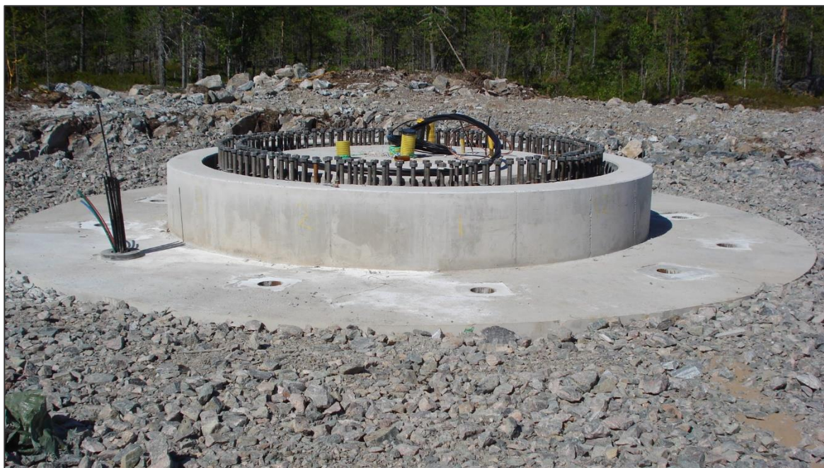
Kuva 3-4. Kallioankkuroitu teräsbetoniperustus. Kuva: YIT Suomi Oy.
