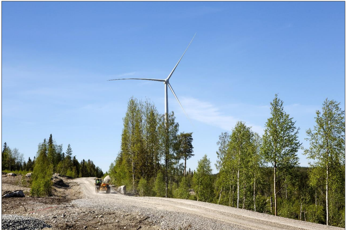
Kuva 3-5. Esimerkkikuva tuulivoimalan huoltotiestä. Kuva: YIT Suomi Oy.
