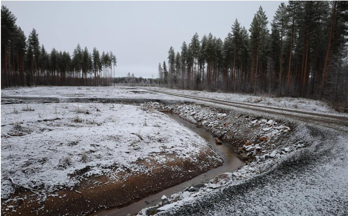
Kuva 3-6. Esimerkkikuva Murtomäen hankkeen tuulivoimalan kokoamis- ja työskentelyalueesta, joka on raivattu puustosta, mutta joka voidaan tuulivoimalan pystyttämisen jälkeen maisemoida.
