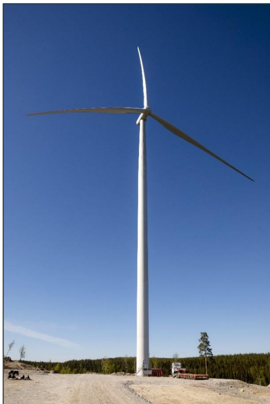
Kuva 3-2. Tuulivoimala terästornilla. Kuva: YIT Suomi Oy.
