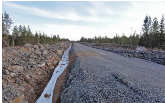
Kuvapari 2-17 Maakaapelit upotetaan huoltoteiden yhteyteen. (Kuvat: Ville Suorsa, FCG)
