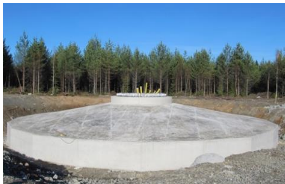
Kuvapari 2-18 Tuulivoimalan perustusten rakentamista. (Kuvat: Leila Väyrynen, FCG)
