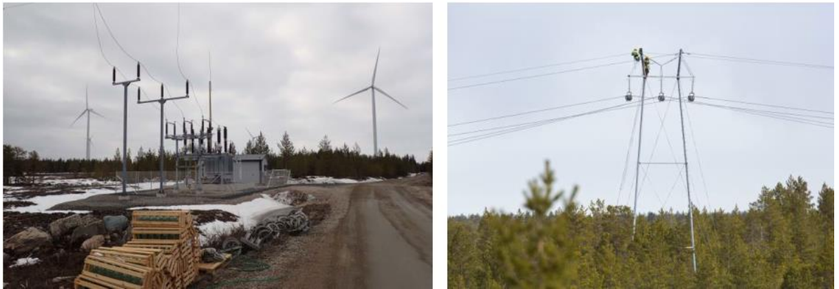
Kuvapari 2.20 Sähköaseman ja voimajohdon rakentamista. (Kuvat: Ville Suorsa, FCG)
