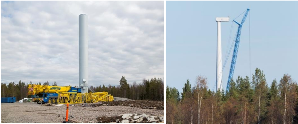
Kuva 2-19 Tuulivoimalan kokoamista. (Kuva: Ville Suorsa, FCG)
