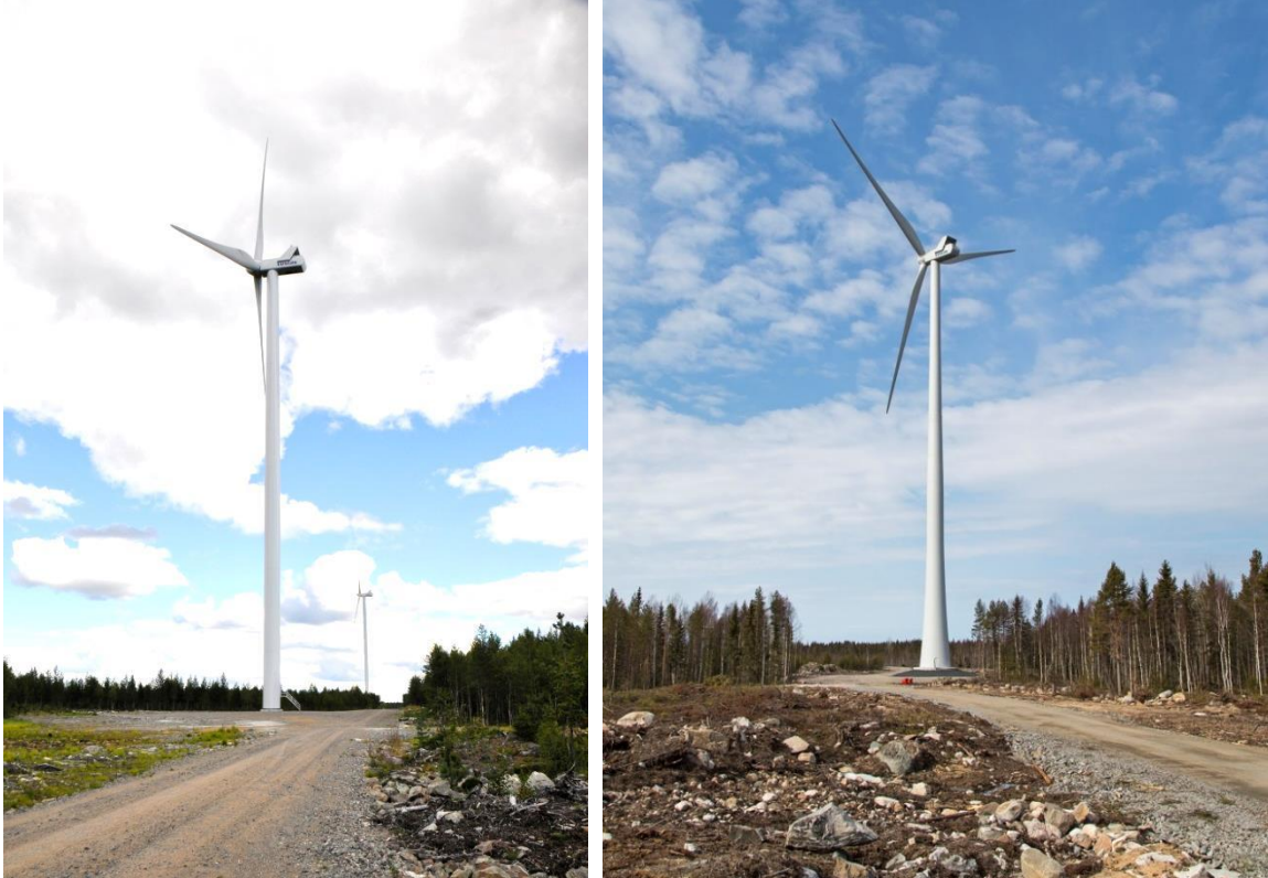
Kuvapari 2-9 Vasemmalla on esimerkki teräslieriötornista ja oikealla hybriditornista. (Kuvat: Leila Väyrynen ja Ville Suorsa, FCG)
