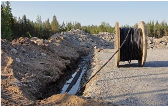
Kuvapari 2-17 Maakaapelit upotetaan huoltoteiden yhteyteen. (Kuvat: Ville Suorsa, FCG)
