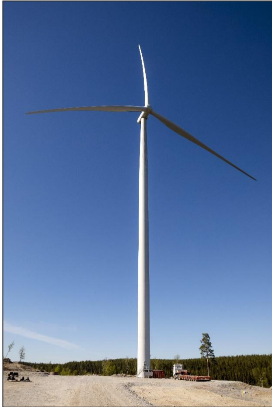
Kuva 3-4. Tuulivoimala terästornilla (YIT Suomi Oy).
