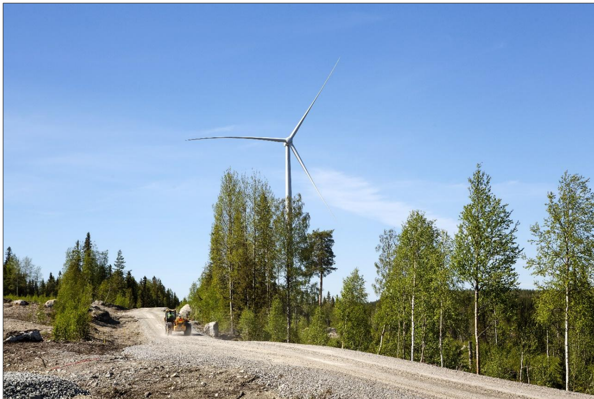
Kuva 3-9. Esimerkkikuva tuulivoimalan huoltotiestä (YIT Suomi Oy).
