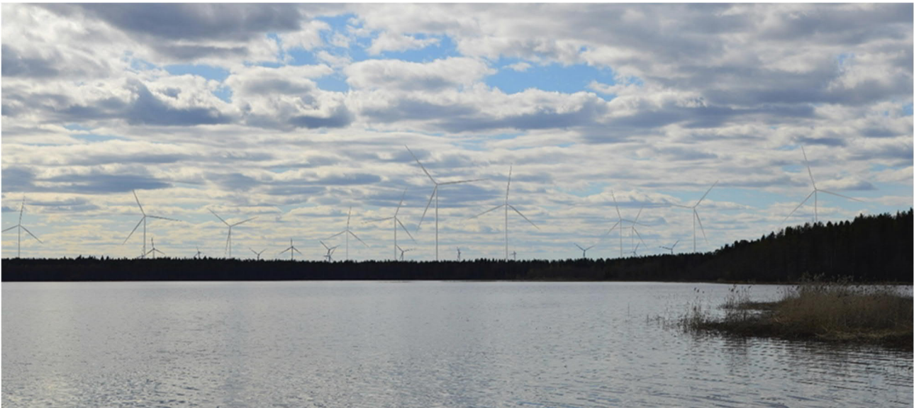
Kuvauspaikkana Parkkimanjärven koillisranta, kuvaussuunta länteen. Kuvassa etualalla näkyvät Kokkopetäikön hankevaihtoehdon voimalat ja taustalla Välikankaan tuulivoimapuiston olemassa olevat voimalat.
