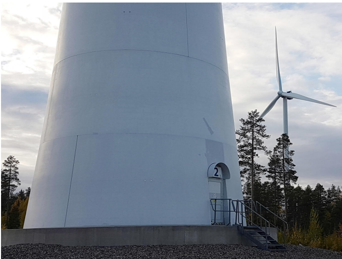
Tuulivoimalan perustusten ja voimalaa ympäröivän kentän rakentaminen voivat muuttaa pinta- ja pohjavesien olosuhteita sekä aiheuttaa vaikutuksia maa- ja kallioperään.
