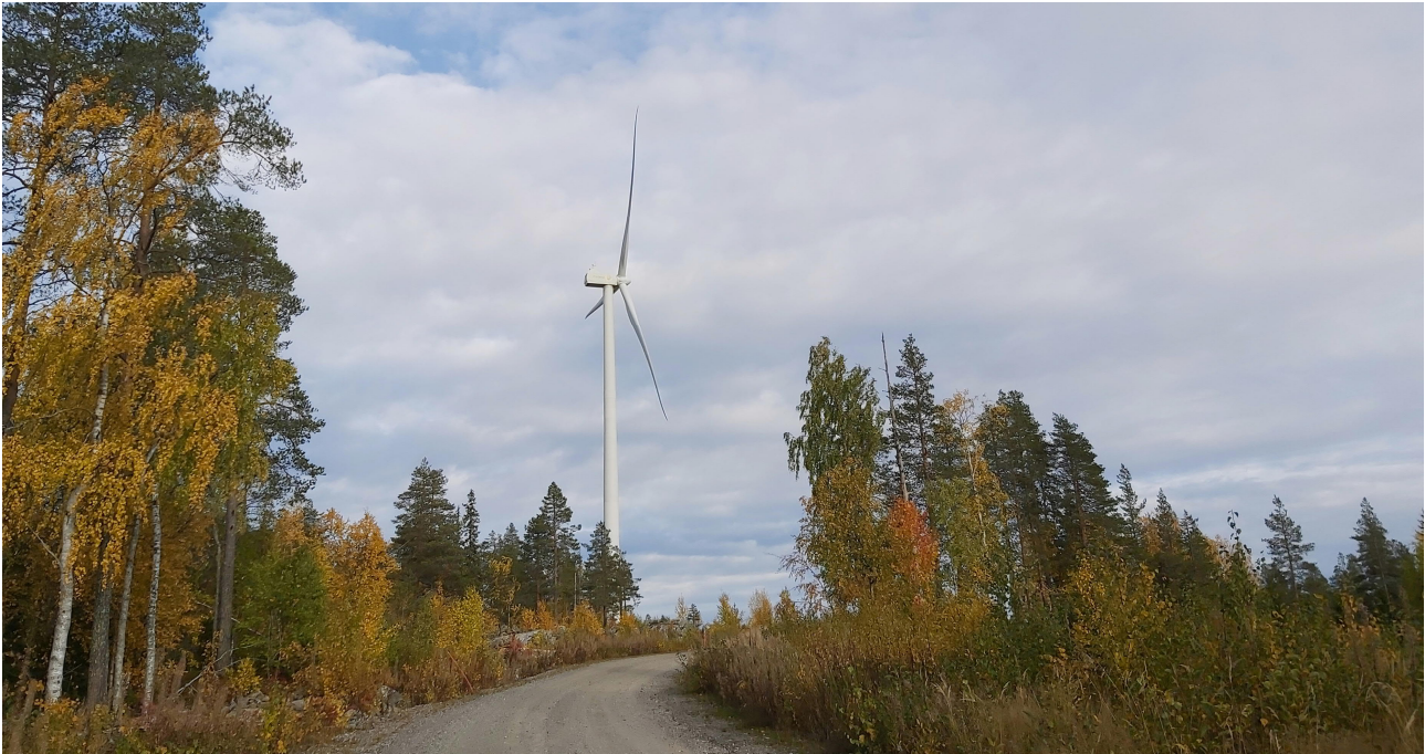
Tuulivoimaloiden rakentaminen ja huoltotoimenpiteet edellyttävät tieverkkoa ja tilaa kunkin turbiinin ympärille.
