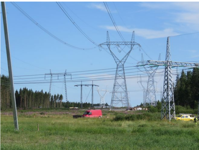
Kuva 33. Haapajärven Pysäysperän uusi sähköasema (rakenteilla)
