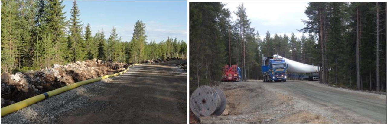
Kuva 78. Vasemmallalla kuvassa on esimerkki tuulivoimapuiston rakennus- ja huoltotiestä. Teitä käytetään muun muassa betonin, soran ja voimaloiden komponenttien kuljetuksiin sekä tuulivoimapuiston käyttöväheessä huoltoajoihin. Maakaapeli sijoitetaan ojakaivantoon tien reuna-alueelle. Oikealla kuvassa tuulivoimalan osia kuljetetaan erikoiskuljetuksina. (Kuvat: Ville Suorsa / FCG).
