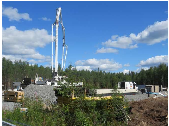
Kuva 32. Murtomäen sähköaseman rakennustyömaa.
