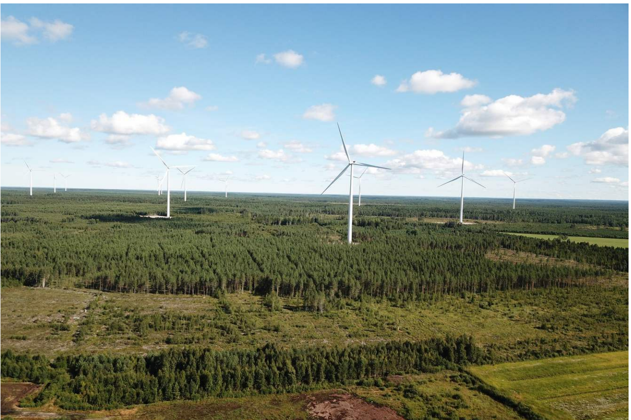
Kuva 29 .Välikankaan tuulivoimapuisto linjauksen pohjoispuolella. Dronekuva pohjoiseen, korkeus 115 m.
