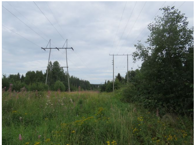
Kuva 42. Ilmajohdon käytävä Pyhäsalmen, etelään.
