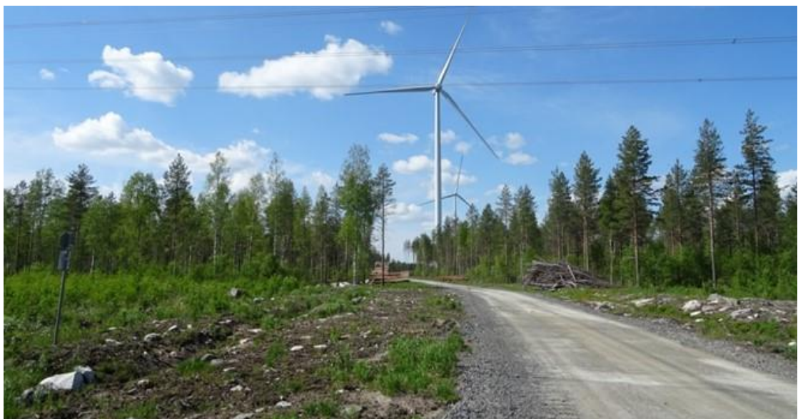
Kuva 12. Esimerkki tuulivoimapuiston rakennus- ja huoltotiestä. Maakaapelin oja on sijoitettu tien vasemmalle puolelle. Teitä käytetään muun muassa betonin ja soran sekä voimaloiden komponenttien kuljetuksiin. Tuulivoimapuiston käyttövaiheessa teitä käytetään mm. vuosittaisissa huolloissa.
